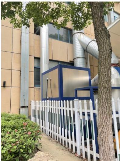
浸漆废气处理装置
