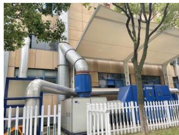
油漆废气处理装置
