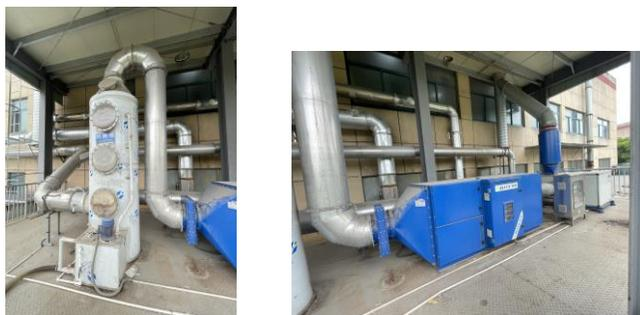
喷塑固化废气处理装置
